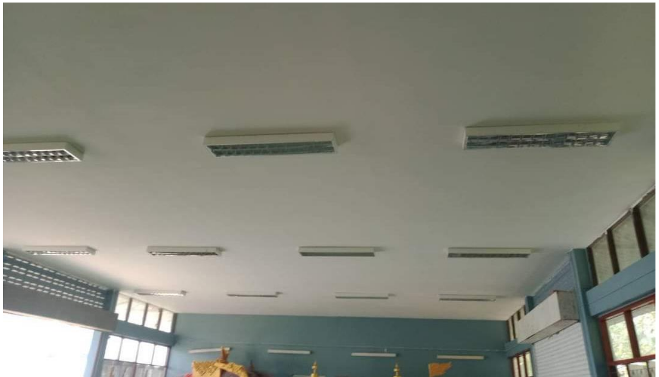
ซ่อมแซมอุปกรณ์ภายในอาคารเรียนและอาคารประกอบ
